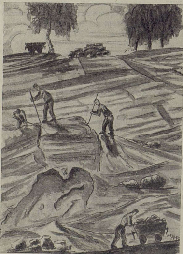
В котловане кипела работа.
