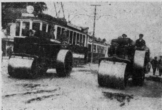
Работа по асфальтированию московских улиц
