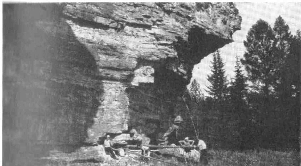
Подведение опоры под глыбу
