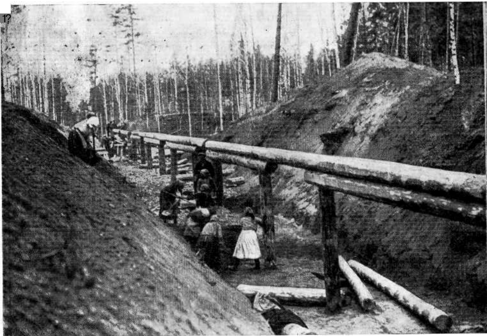
Общий вид строящейся эстакады лесовозной дороги в Кашкинском районе Западно-Сибирского края. 1931 г.
