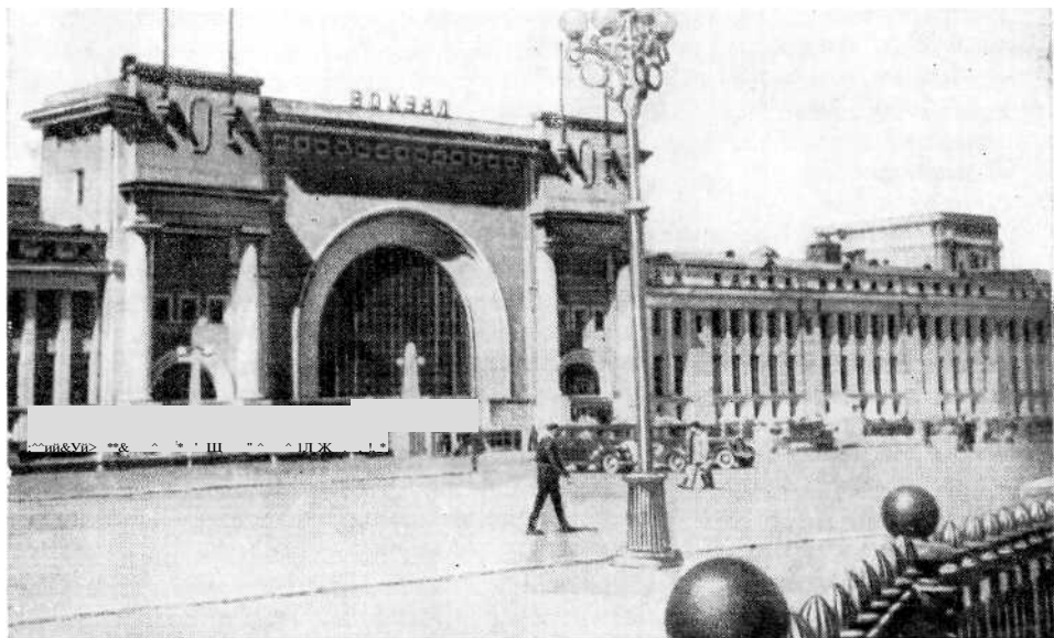
Новый железнодорожный вокзал в г. Новосибирске.
