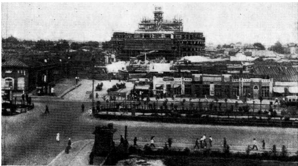
Строительство театра оперы и балета в Новосибирске. 1933 г.
