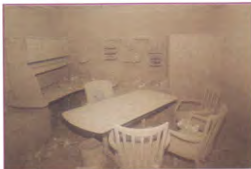
Помещение, покрытое пылью от разрушения башен ВТЦ 11 сентября 2001 года
