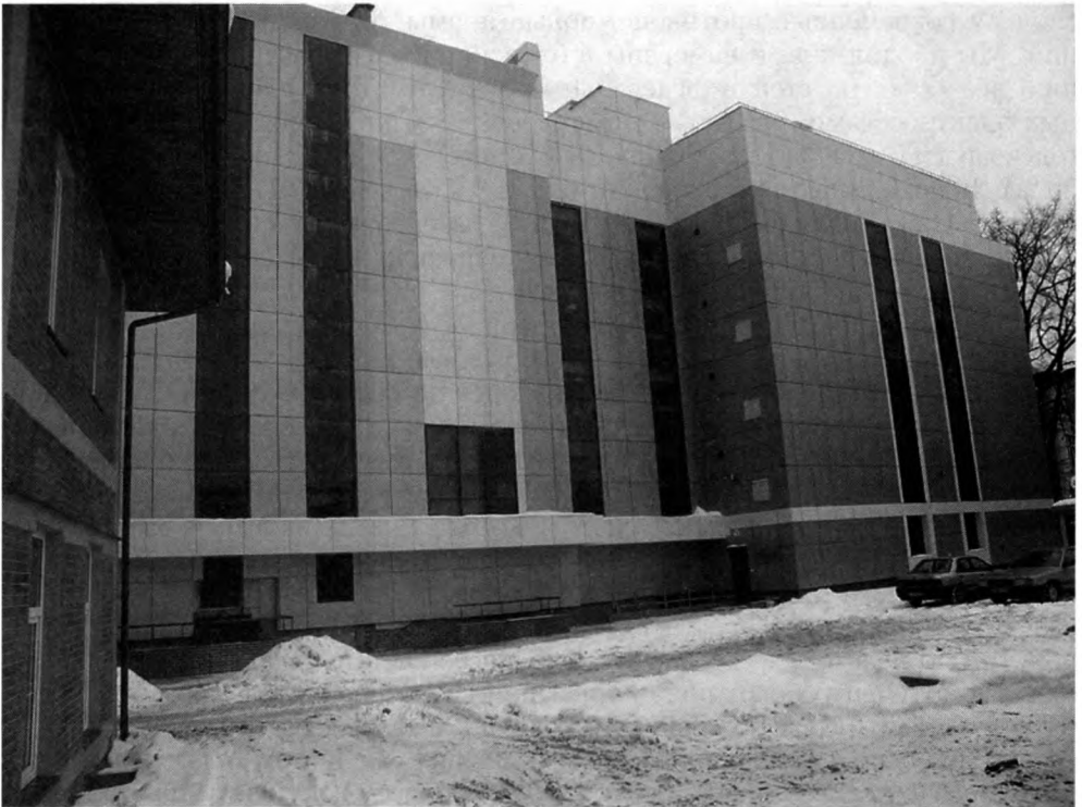
Новое здание Госархива Калининградской области
