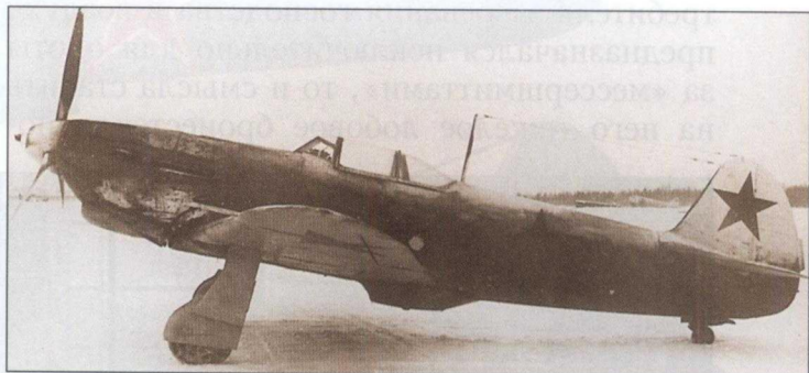
Истребитель Як-1 с форсированным мотором ВК-105ПФ. Фонарь кабины получил круговой обзор, что ценилось выше, чем прибавка в скорости на несколько км/ч
