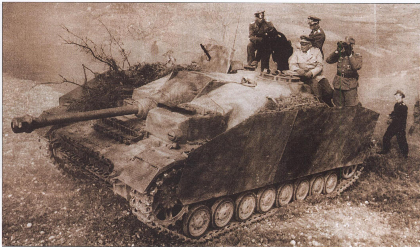
«Штурмгешутц» IV. Обратите внимание на рубку водителя сбоку от орудия
