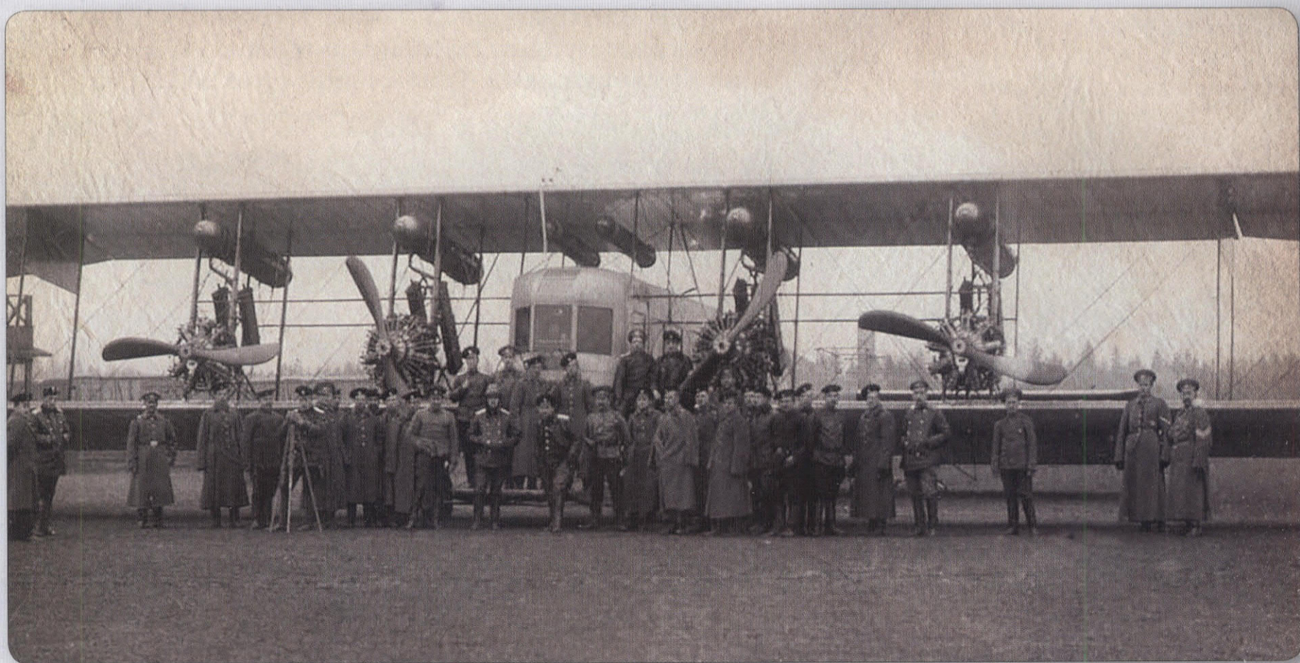
Самолет «Илья Муромец» серии Б с моторами воздушного охлаждения «Сальмсон» (два мощностью по 200 л.с. и два мощностью по 135 л.с.)
