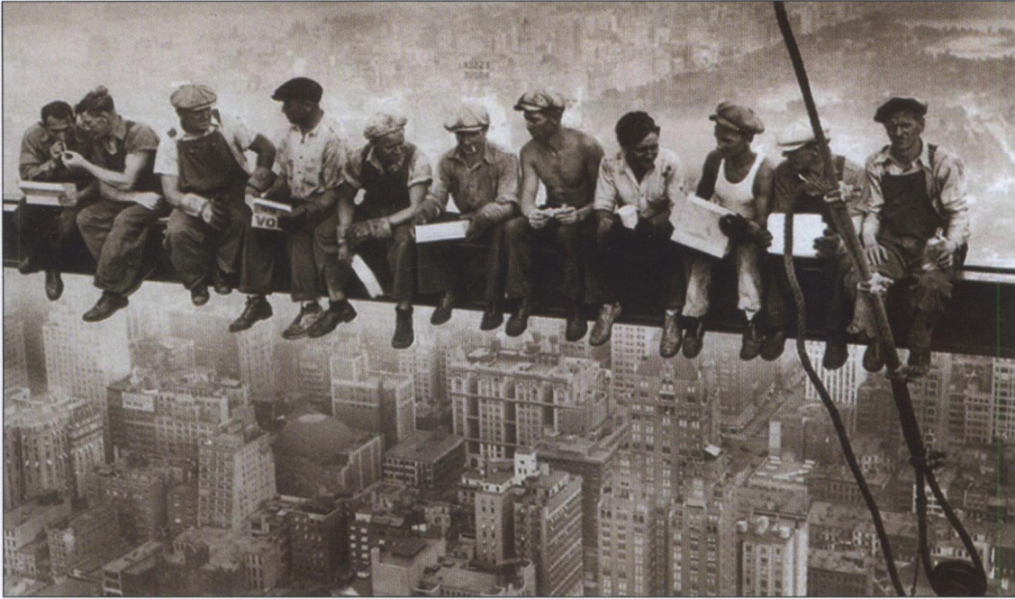
Строители небоскреба во время обеденного перерыва
