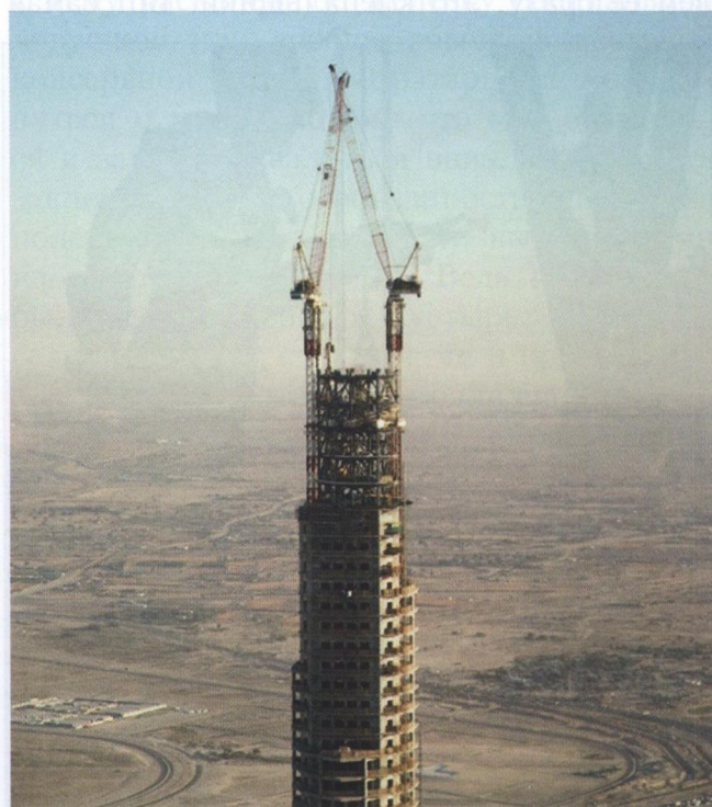
Сборка железного каркаса верхней части «Дубайской башни»
