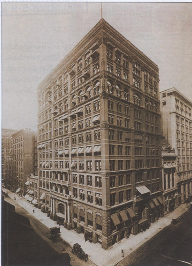
Первый в мире настоящий небоскреб — здание страховой компании Хоум Иншурэнс в Чикаго
