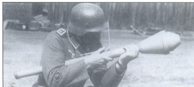
Немецкий одноразовый гранатомет «Фаустпатрон» стал эффективным противотанковым оружием пехоты
