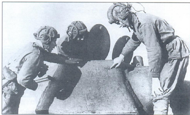
Экипаж Т-34 рассматривает след рикошета от вражеского снаряда на броне
