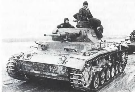
Основной немецкий танк начала войны "Панцер-III". Пушка калибра 50 мм, броня — 30 мм.
