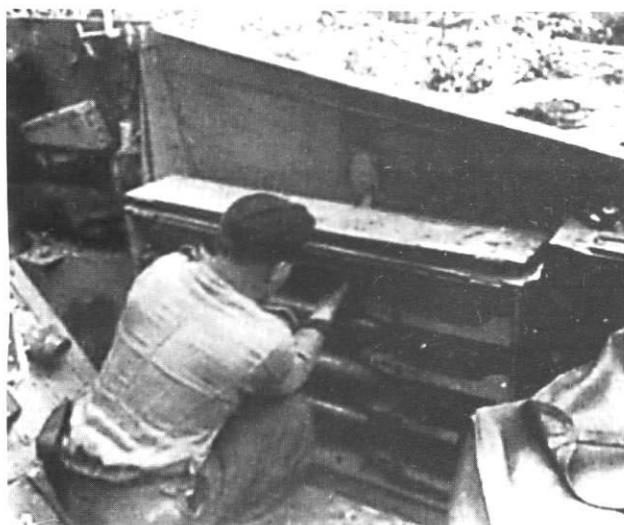
Размещение боекомплекта в рубке «Насхорна»
