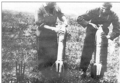
Оружейники готовят реактивные снаряды РС-132 для подвески под Ил-2
