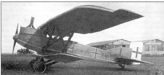
Тяжелые потери среди ударных машин привели к идее бронировать самолет. Первой такой попыткой стал немецкий штурмовик Юнкерс J-1.
