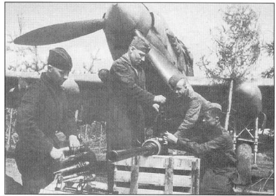
Оружейники готовят пушку ИС-37 для установки на Ил-2
