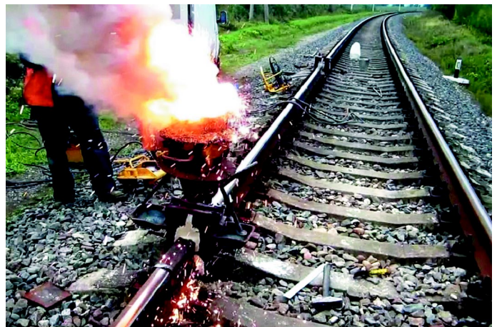
5. Сварка стыков «бархатного» пути.
