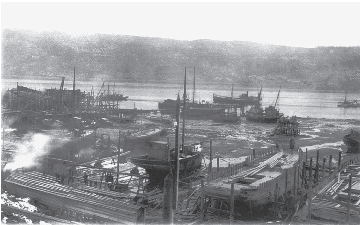
Верфь деревянного судостроения
