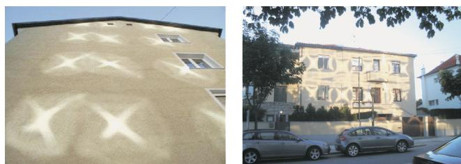
Рис.5. Отражение от пластиковых окон
