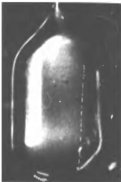
Рис. 1. Первая пузырьковая камера Д.Глейзера. Ее объем всего лишь  $2,5 \text{ см}^3$ . Сосуд из толстого стекла наполнен эфиром, который находится под давлением и не кипит. Если давление снять, эфир окажется в перегретом состоянии и может оставаться в нем довольно долго. Прошедшая через камеру космическая частица вызывает образование пузырьков по своему следу, после чего начина-
