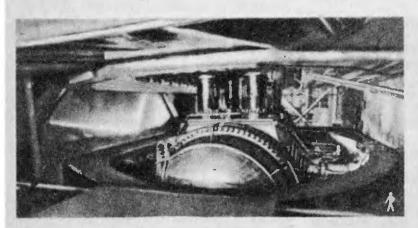
Рис. 1. Пузырьковая водородная камера «Мирабель», используемая для исследований в Институте физики высоких энергий.
