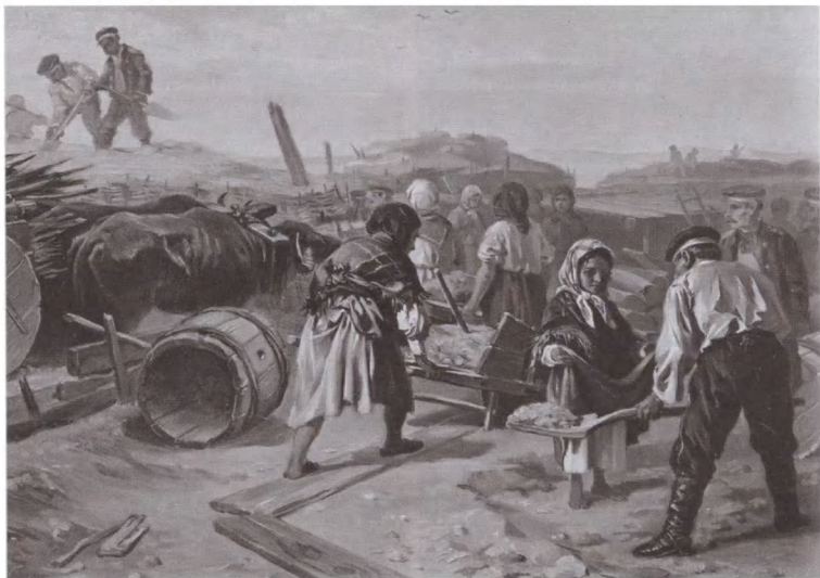
Строительство укреплений в Севастополе. И. М. Прянишников. 1871—1872 гг.
