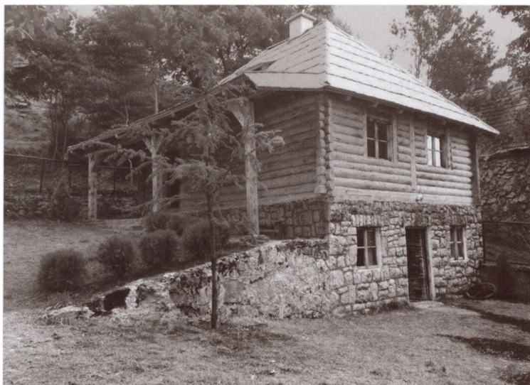
Дом Принципов в Обляе после реконструкции 2014 года
