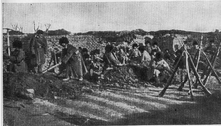
Работы на укреплениях в Порт-Артуре.
