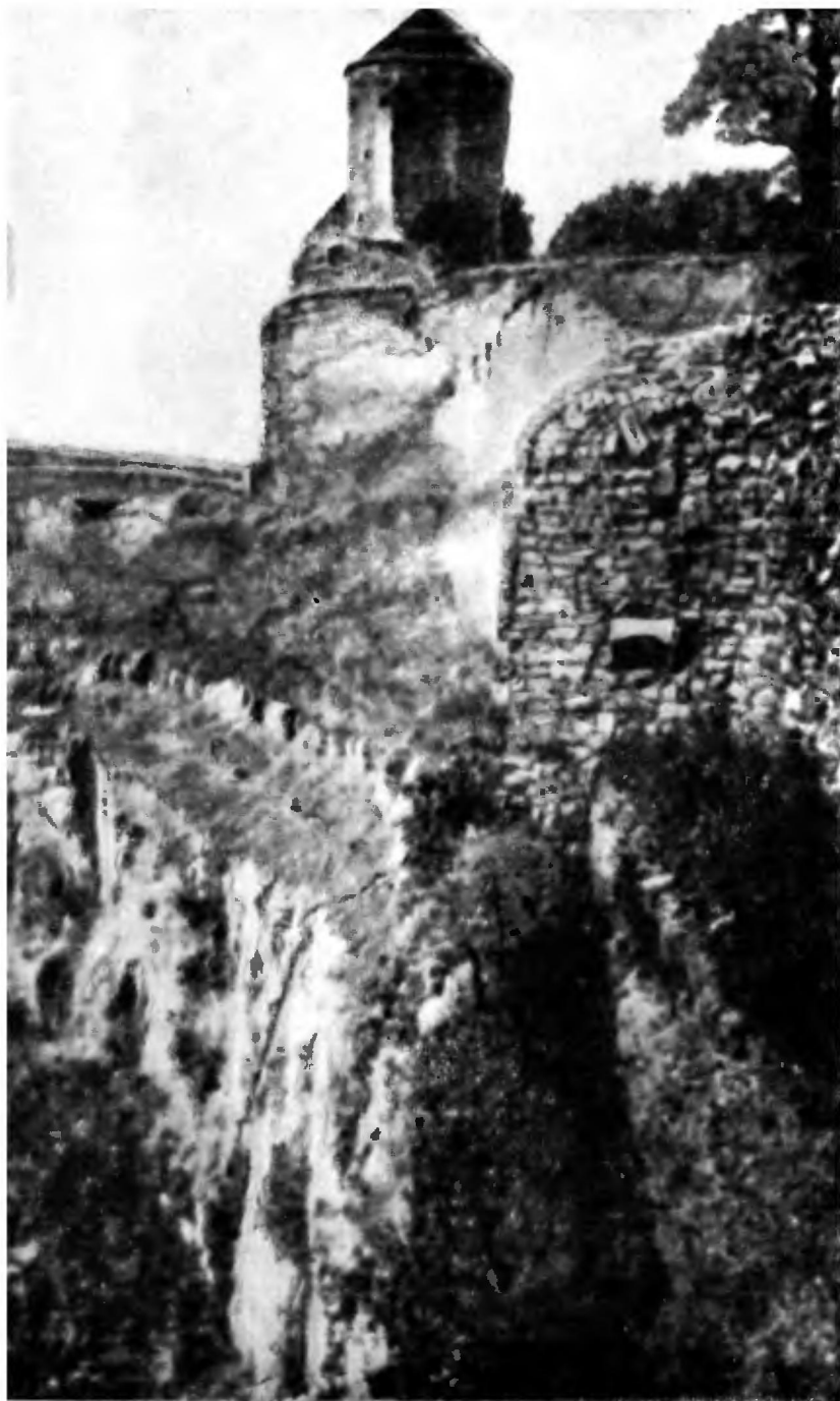
Часть стены и башня Каменец-Подольской крепости,
