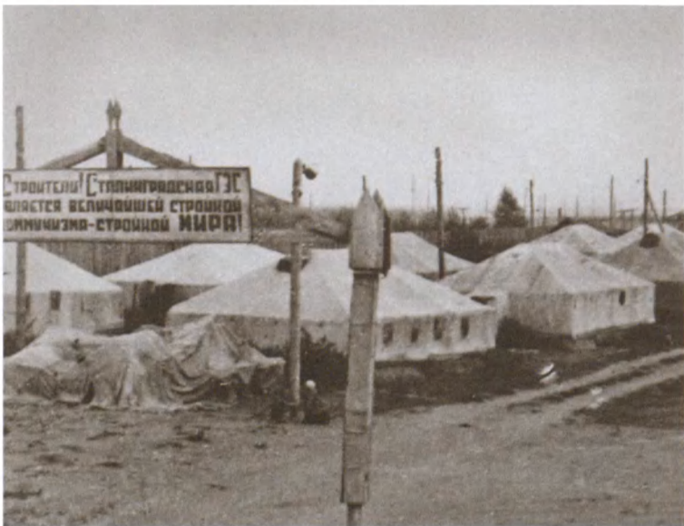
Палаточный городок первых строителей Сталинградской ГЭС
