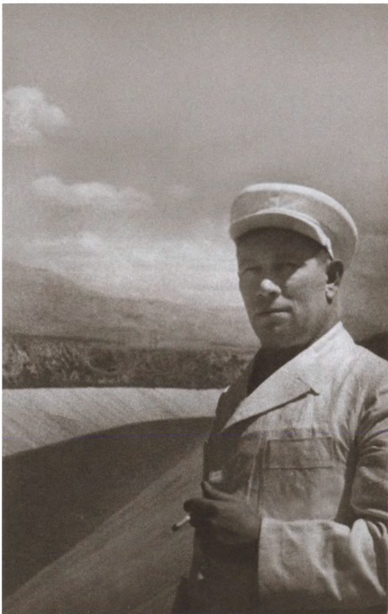
Гидростроитель Фёдор Логинов. У деривационного канала
