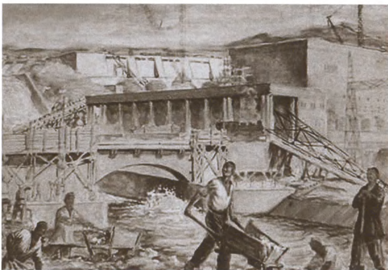
На строительстве Чирчикской ГЭС. Художник К. П. Чепраков
