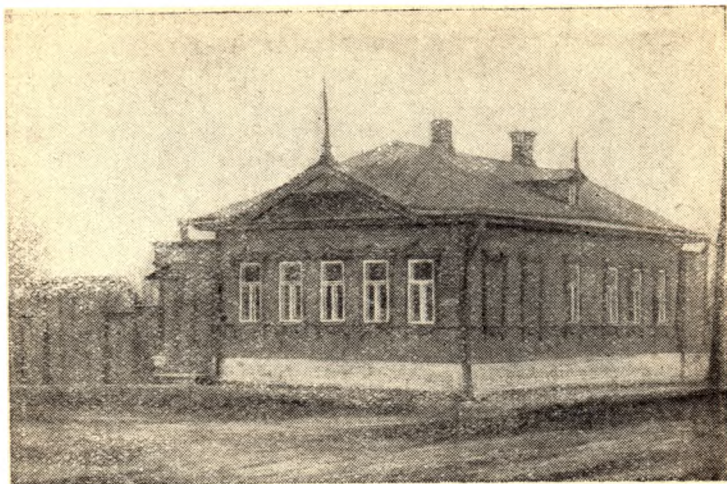
Новый дом Циолковского в Калуге.
