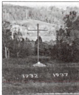
Памятник погибшим при строительстве канала Москва — Волга (1932–1937)
