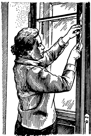
Рис. 27. Герметизация квартиры
