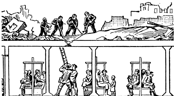
Рис. 37. Пробивание отверстия в перекрытии убежища
