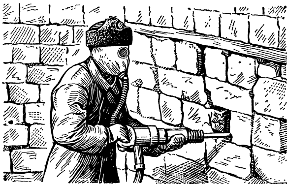
Рис. 36. Пробивание отверстия в стене убежища
