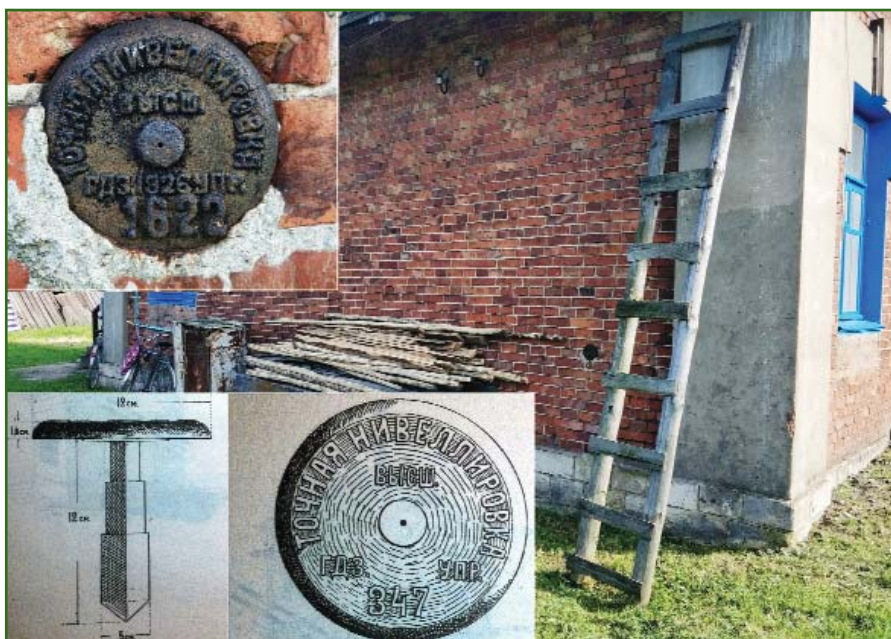
Рис. 6 Чертеж марки ВГУ [13] и фото марки № 1622 в стене здания разъезда Руново (июнь 2020 г.)
