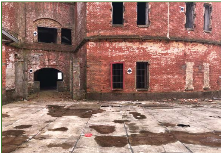
Рис. 10 Опорные точки на фасаде форта «Александр I» и на земле
