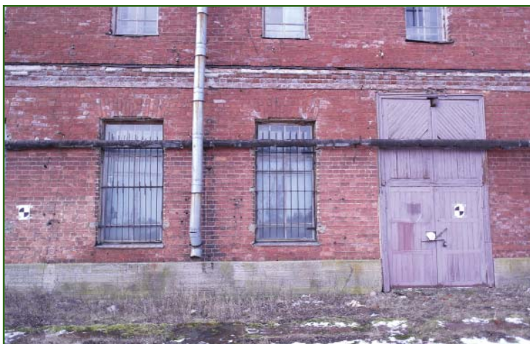
Рис. 3 Пример размещения опорных точек на фасаде форта «Петр I»
