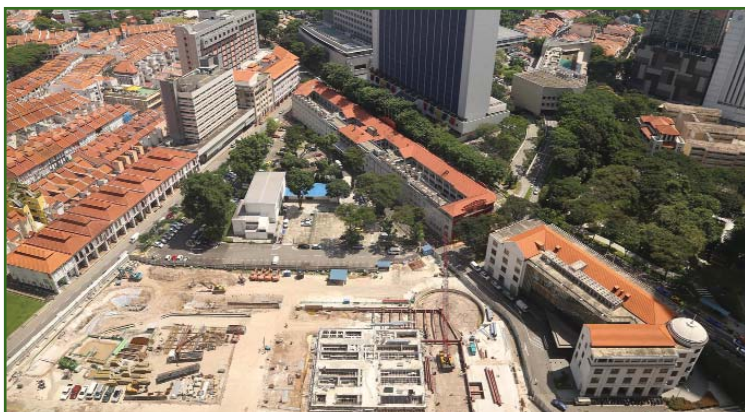
Рис. 3 Вид строительной площадки башни Guoco Tower с существующими зданиями
