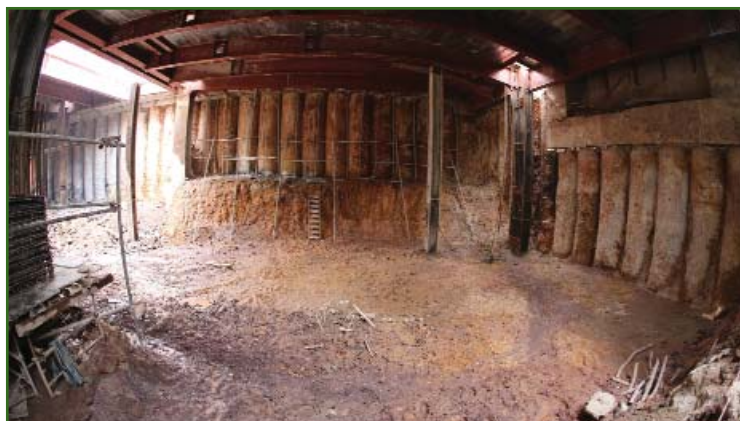
Рис. 6 Буронабивные сваи фундамента башни
