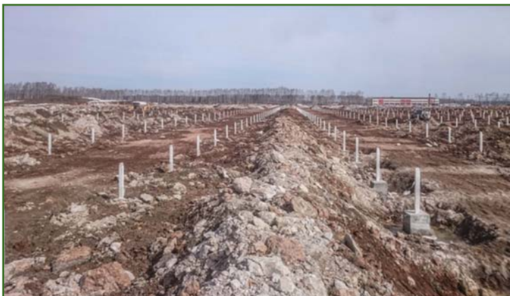
Рис. 3 Строительная площадка с установленными опорными столбиками
