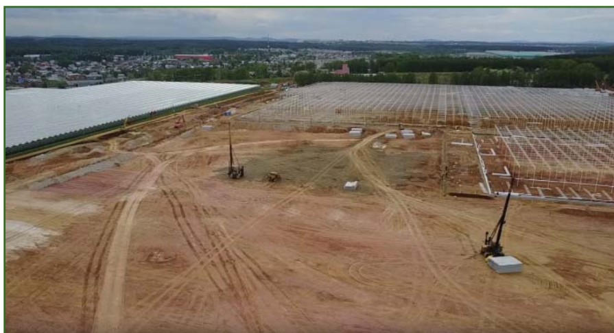
Рис. 1 Общий вид строящегося тепличного комплекса
