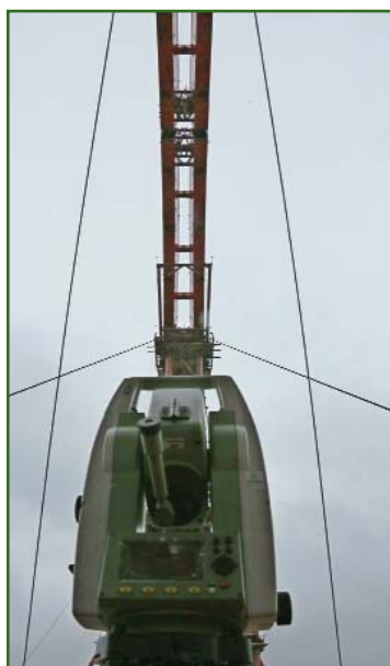
Рис. 8 Измерение координат контрольных точек арки с помощью электронного тахеометра Leica TS02
