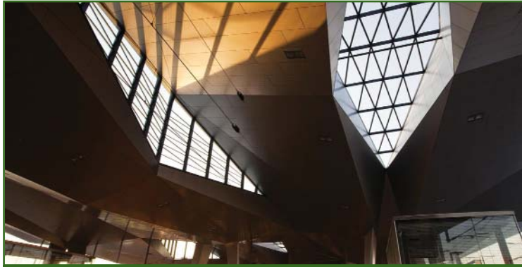
Рис. 2 Внешний вид кровли с железнодорожной платформы
