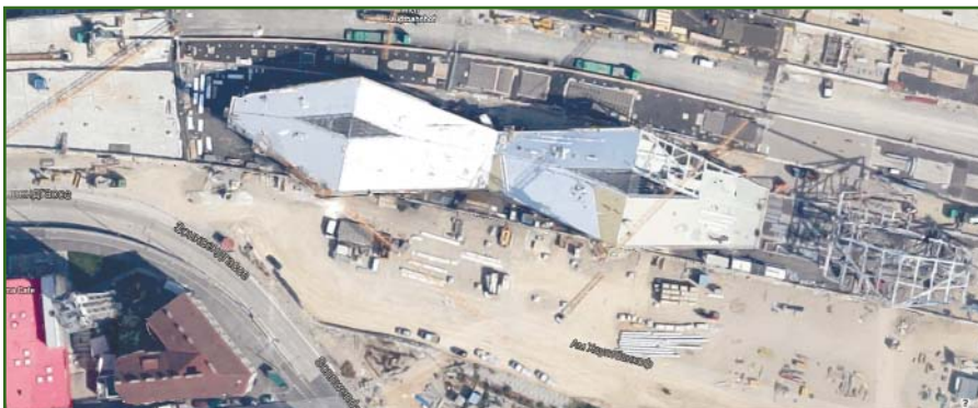
Рис. 5 Сборка ферм кровли над платформами и путями ( www.google.ru/maps )
