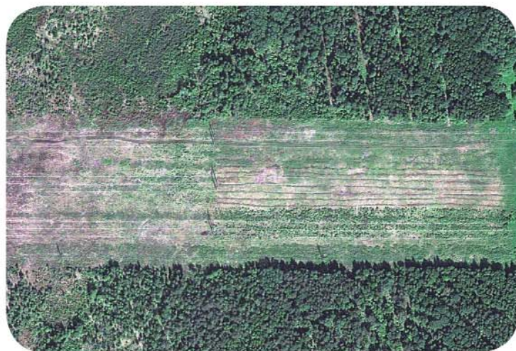
Линии электропередач в районе Ленинградской АЭС на снимке GeoEye-1
