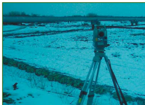
Рис. 3 Наблюдения на надземном переходе магистрального газопровода «Союз»
