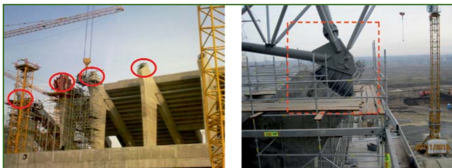
Рис. 4 Места установки и расположение опорных деталей навеса
