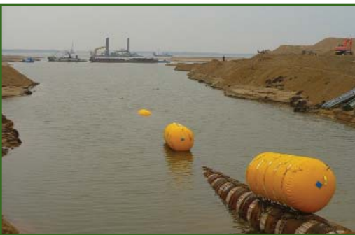
Рис. 7 Балластировка подводного перехода
