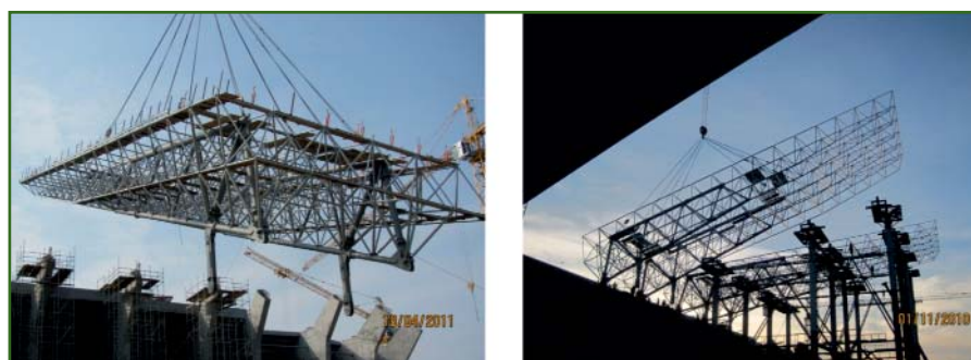
Рис. 5 Монтаж секций навеса
