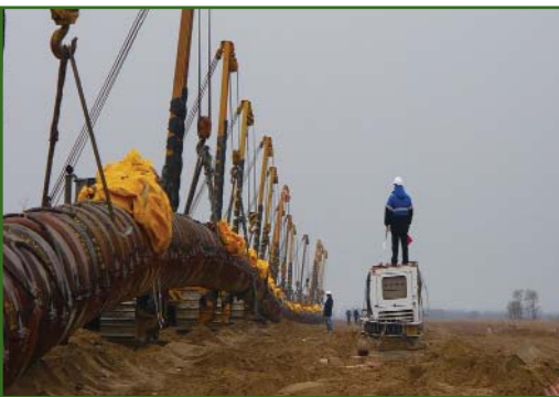
Рис. 6 Укладка трубы
