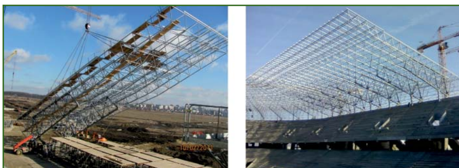
Рис. 9 Установка секции крыши и готовая крыша
