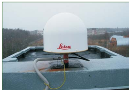
Рис. 3 Антенна Leica AR25 класса Choke-Ring, установленная на крыше здания
