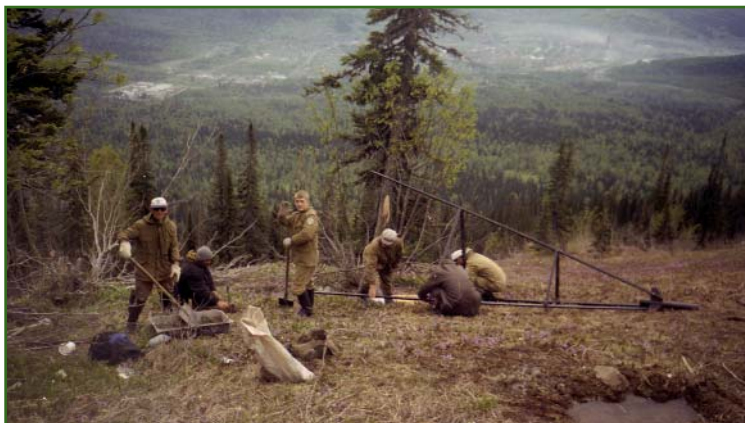
Рис. 2 Установка пункта полигонометрии
