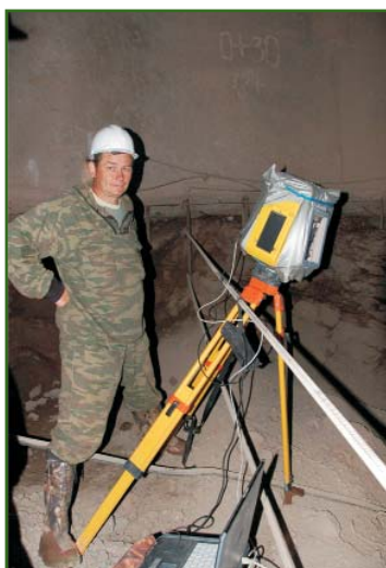
Рис. 5 Съемка сканером подземного сооружения
