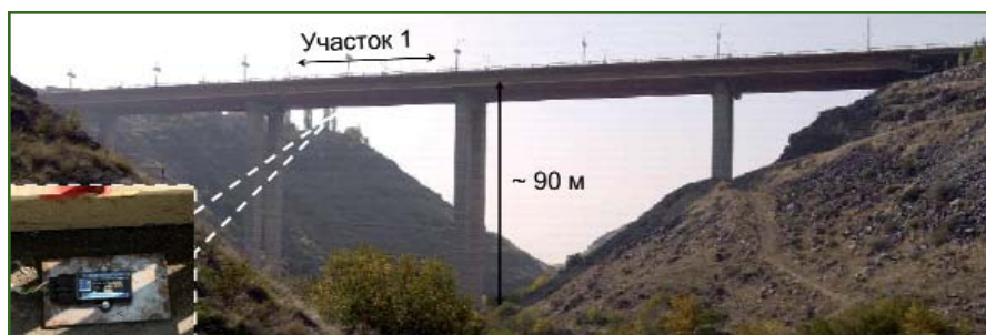
Рис. 5 Давидашенский мост в Ереване с обозначенным участком измерений
