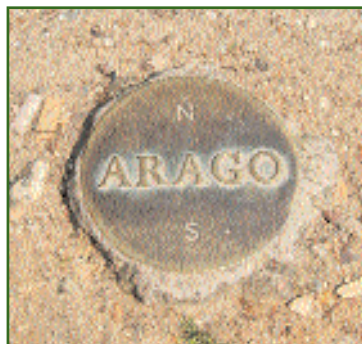
Рис. 10 Одна из 135 бронзовых марок, закрепляющих положение Парижского меридиана
