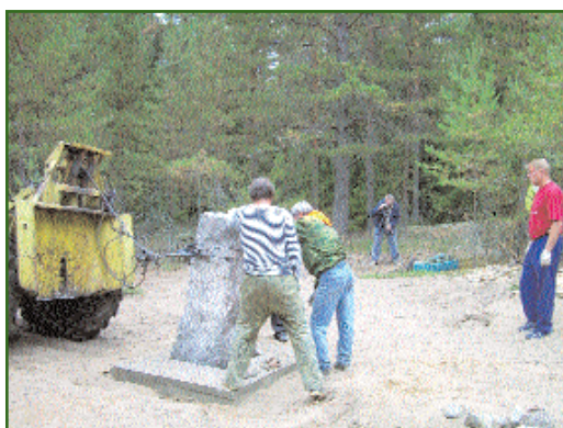
Рис. 2 Установка астрономического гранитного столба
