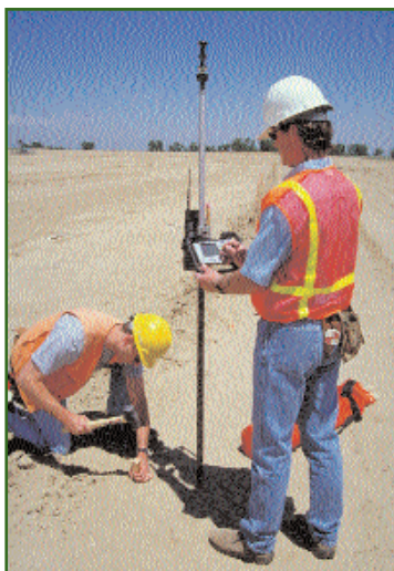
Рис. 4 Контроллер АСУ на активной вешке. Вынос точек в натуру
