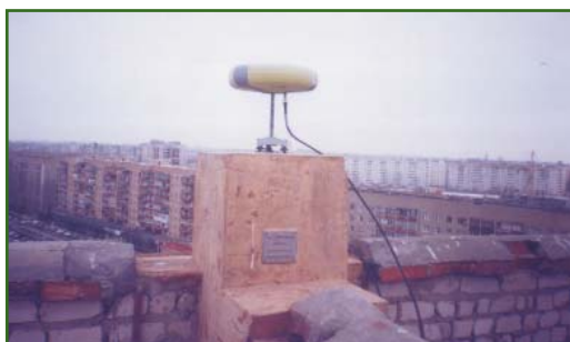
Рис. 4 Спутниковая антенна, установленная над геодезическим центром ФАГС
