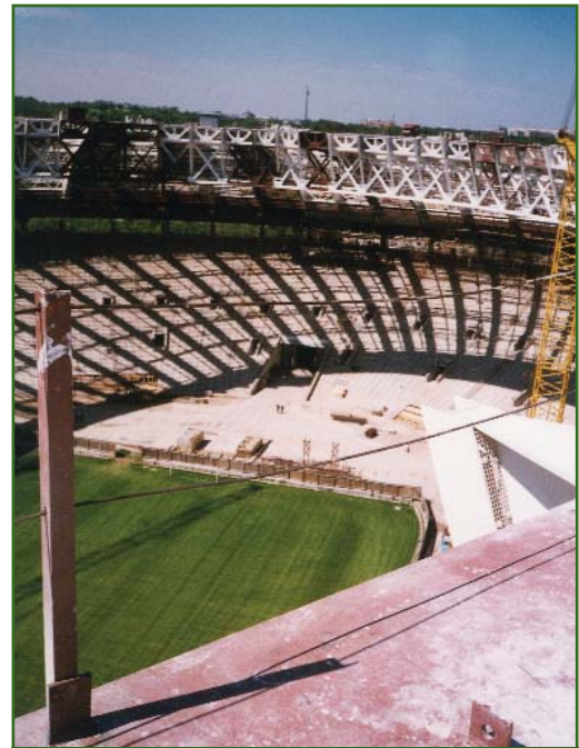
Рис. 1 Монтаж перекрытия БСА стадиона в Лужниках
