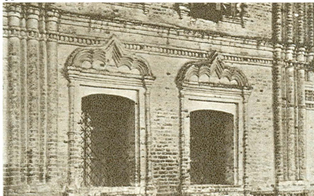
Левашево. Воскресенская церковь. Фрагмент
