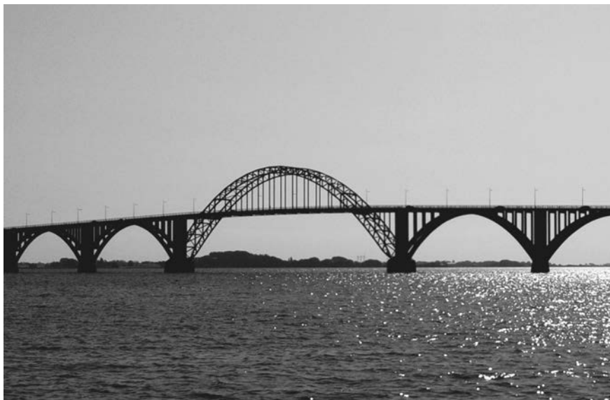
Рис. 1.2. Мост королевы Александрины (Queen Alexandrine Bridge) — арочный мост через пролив Ульвсунн между островами Зеландия и Мён в Дании. Был открыт в 1943 году
