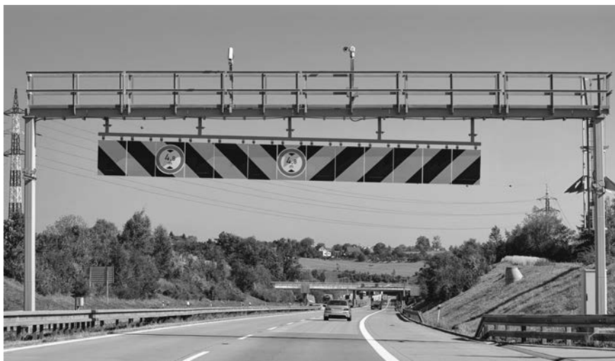
Рис. 8.4. Барьер с ограничителем высоты. Слишком высокий грузовик не сможет проехать, так как врежется в ограничитель, но с небольшим ущербом
