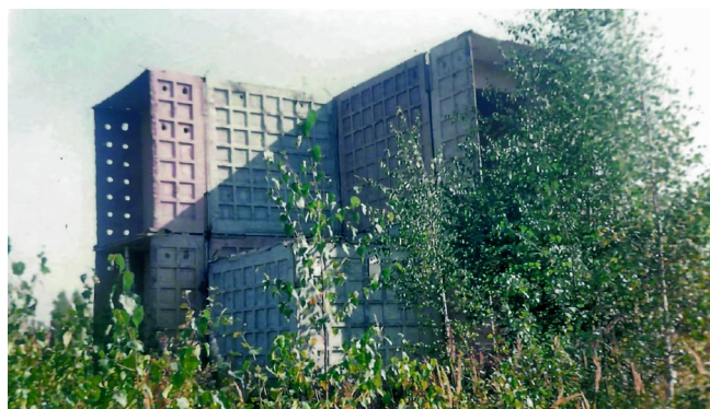
Рис. 1. Фрагмент здания из блок-модулей Fig. 1. A fragment of a building made of block modules
