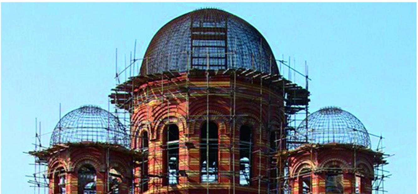
Рис. 4. Монтаж арматурных каркасов куполов Fig. 4. Installation of dome reinforcement frames
