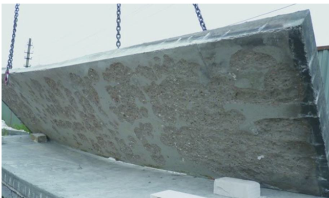
Рис. 6. Вид обогреваемой поверхности плиты серии 6 (9 % микрокремнезема в ВБ) после огневого испытания. Класс бетона – В80
