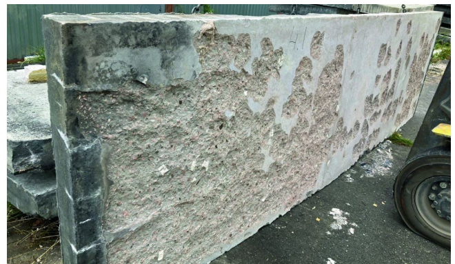
Рис. 7. Вид обогреваемой поверхности плиты серии 4 (9 % микрокремнезема в ВБ) после огневого испытания. Класс бетона – В100
