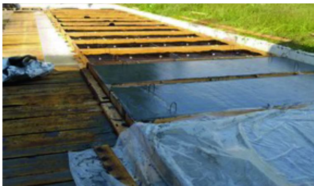
Рис. 1. Фрагмент процесса изготовления натуральных плит на площадке НИЭЦ «Стройтест»
