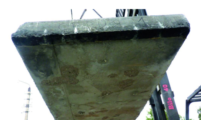
Рис. 4. Вид обогреваемой поверхности плиты серии 1 (6,75 % микрокремнезема в ВБ) после огневого испытания Fig. 4. View of the heated surface of the series 1 plate (6.75 % of microsilica in HSC) after the fire test
