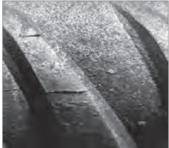
Рис. 1. Общий вид трещин в поперечных ребрах арматурного проката диаметром 40 мм
