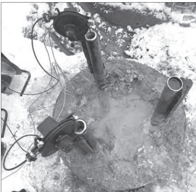
Рис. 2. Ультразвуковые сенсоры и датчики погружения в рабочих позициях на каналобразующих трубах испытываемой сваи
