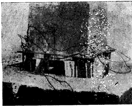
Рис. 1. Металлическая рама с ТЭНами для предварительного отогрева полости стыка
