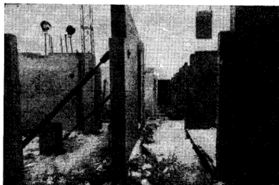
Рис. 2. Обогрев уложенного в стык бетона ТЭНами, смонтированными в специальном кожухе. Сверху кожух утеплен шлаковатой
